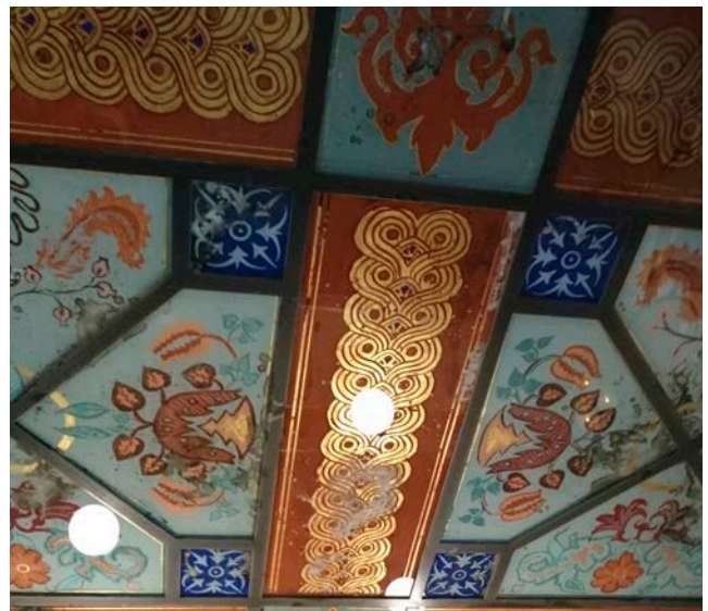
Plafond décoratif, structure métallique avec verre peint.
