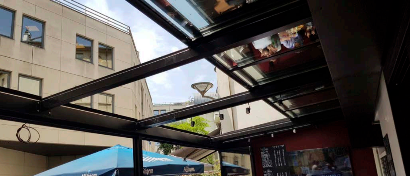
Toiture motorisée de restaurant.
